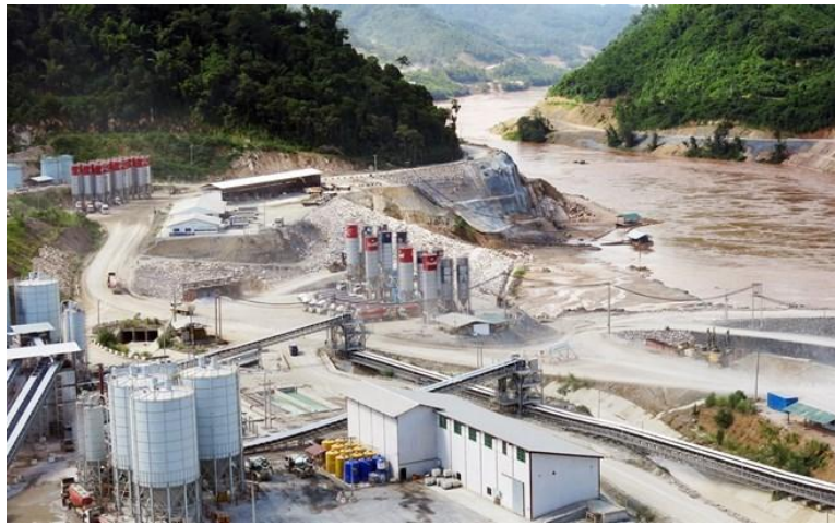
Đập Thủy Điện Xayaburi trên dòng chính của sông Mê kông đang được xây dựng (Nguồn AFP)
